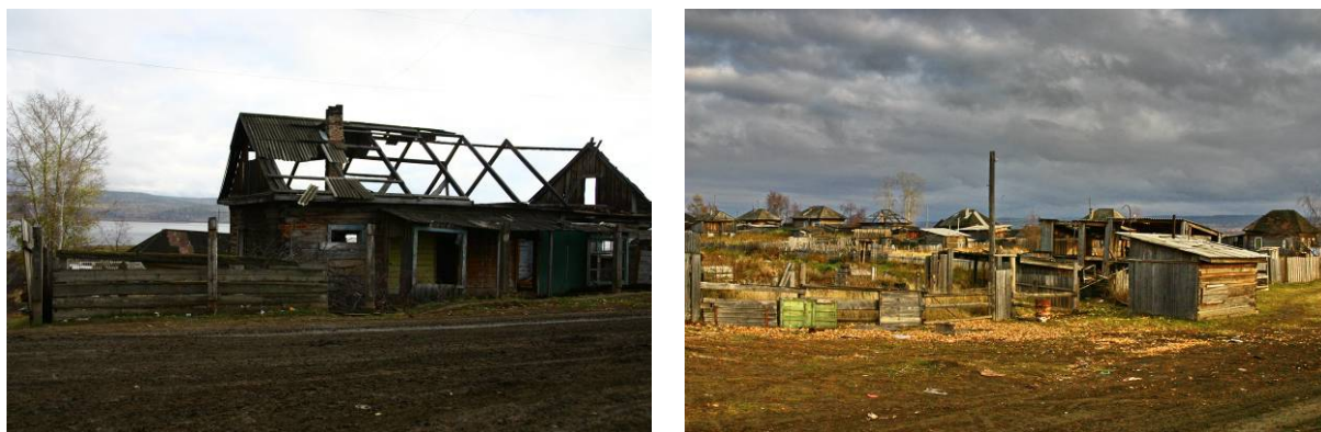
Рисунок 3. Разрушенные жилые дома
